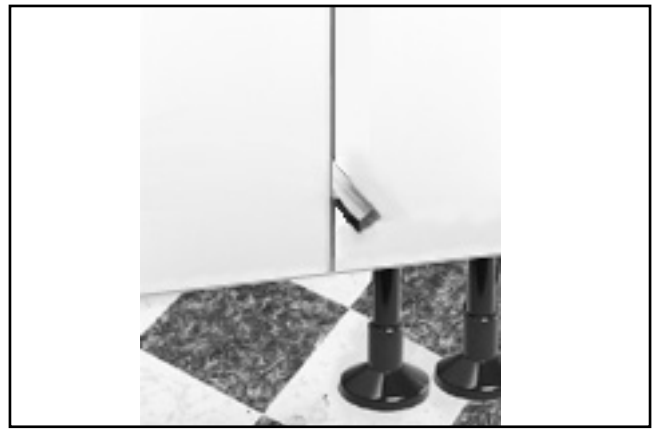
untere Türluft (Ansicht Kabine innen)
