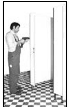
Nun werden die Türen, an denen die Bänder schon angebracht sind, an die Mittel und Seitenteile angeschraubt.
