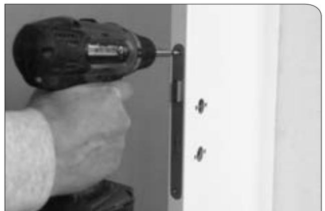
Bei den Türen ist darauf zu achten, dass eine Luft von 5 mm an der Schloßseite eingehalten wird.
