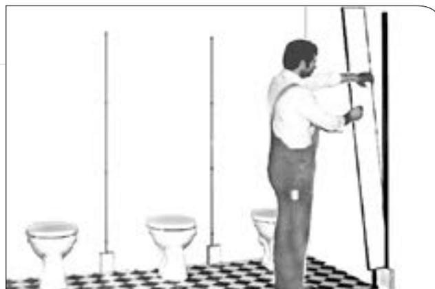
Auf das **Mittelteil** wird unten bündig das U-Profil (nach Maßangabe in der Zeichnung) gelegt, die Bohrlöcher markiert, das U-Profil mit Schrauben 4,8 x 16 mm befestigt (4,3 mm vorbohren) und die Stützfüße eingeschlagen.
