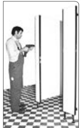
Nun werden die **Türen** mit Schrauben 5 x 60 an die Bänder geschraubt. Dafür müssen zuerst 8 mm Dübel in die Tür eingesetzt werden. Die 4 Bohrlöcher sind bereits im Türblatt vorgebohrt. **Achtung!** unbedingt darauf achten, dass die Spreizrichtung des Dübels in Längsrichtung der Tür zeigt.
