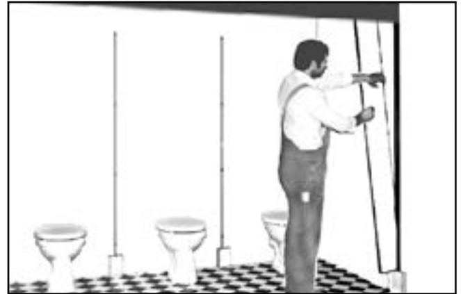
Auf das **Mittelteil** wird unten bündig das U-Profil (nach Maßangabe in der Zeichnung) gelegt, die Bohrlöcher markiert, das U-Profil mit Schrauben 4,8 x 16 mm befestigt (4,3 mm vorbohren).
