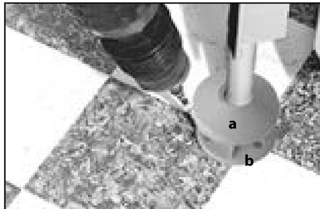
Alle Teile an den U-Profilen befestigen (4,8 x 16 mm Schrauben).
