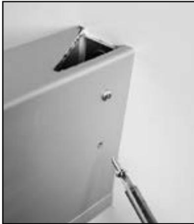
Nun werden die Abdeckprofile (HR) auf die Winkel aufgelegt und verschraubt.
