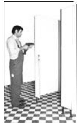
Nun werden die **Türen** an die Bänder geschraubt. Hierbei ist darauf zu achten, dass die Türluft von 5 mm an der Schloßseite eingehalten wird. Zur Hilfe können Holzkeile verwendet werden.
