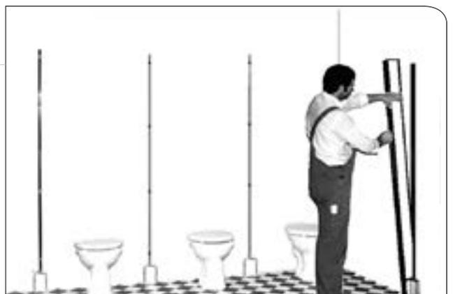
Auf das **Mittelteil** wird unten bündig das U-Profil (nach Maßangabe in der Zeichnung) gelegt, die Bohrlöcher markiert, das U-Profil mit Schrauben 4,8 x 16 mm (4,2 mm vorbohren) befestigt.
