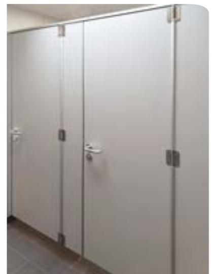
Pour les portes qui s'ouvrent vers l'extérieur, les paumelles et le profilé anti-pincement sont visibles sur la surface.
